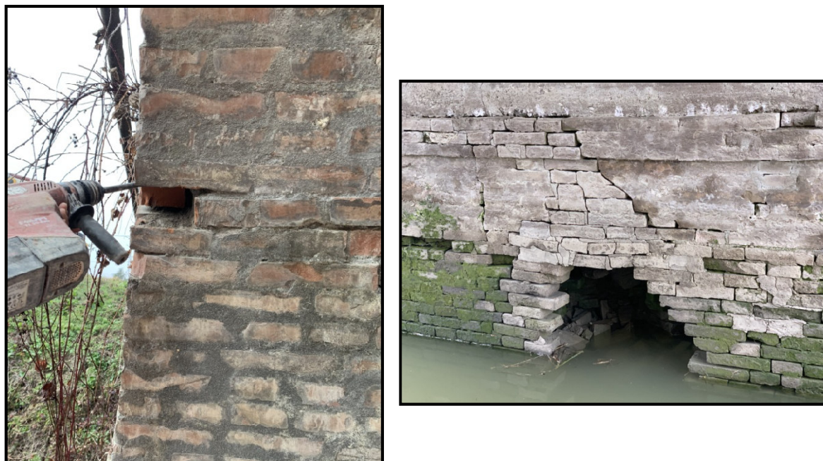
Figura 10 – A sinistra prelievo di mattone in opera; a destra cavità presente in spalla.
