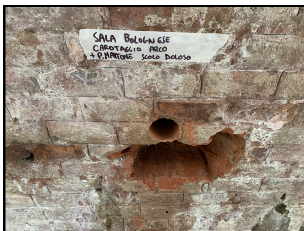
Figura 7 – A sinistra carotaggio eseguito in Arco (rene); a destra carotaggio eseguito in spalla.
