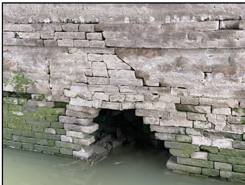
Figura 5 – Cavità presente su spalla.
