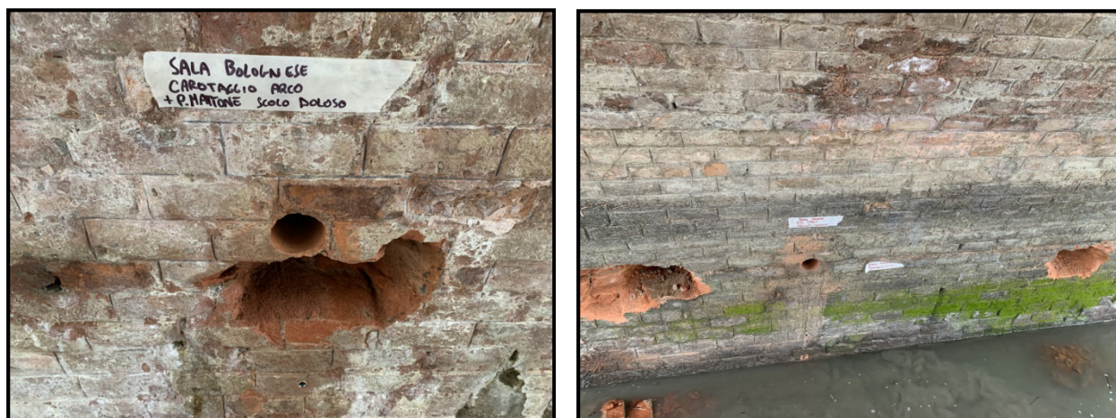
Figura 9 – Prelievi di mattone nelle spalle.
